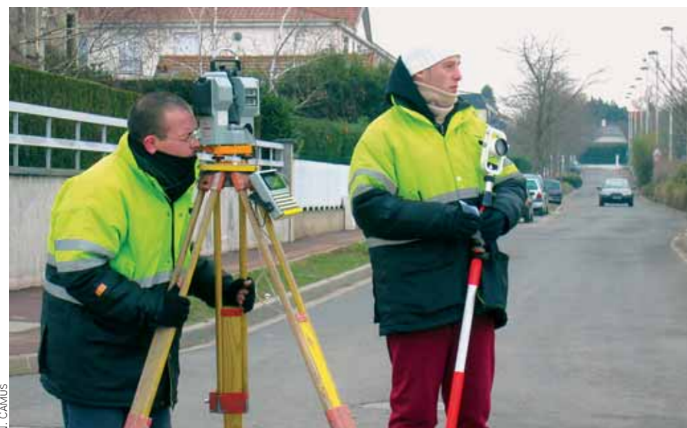
Première étape, le bornage sur le terrain...
